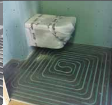
Prefab inslijpen XPS paneel badkamer in opdracht van LOGUS -Prefab badkamers
