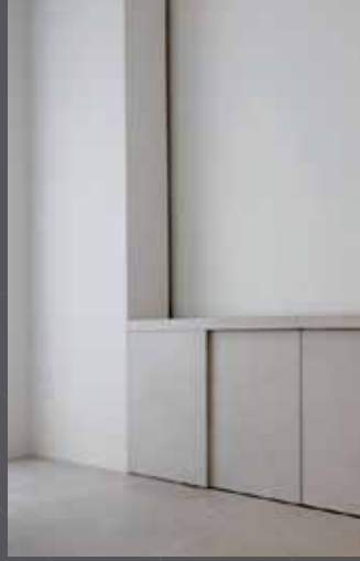
Belediyeye ait anıtsal binanın renovasyonunda uygulanan duvar ısıtması Keizersgracht (Amsterdam)
