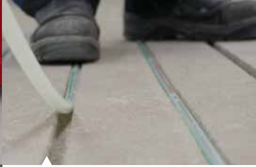
JK Flextube ısıtma boruları açılan kanallara yerleştirilir
