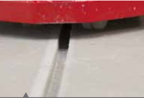
Patentli freze makinesiyle tozsuz kanal açılır.
