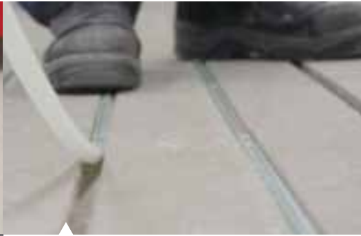
JK Flextubes borular kanallara yerleştirilir.
